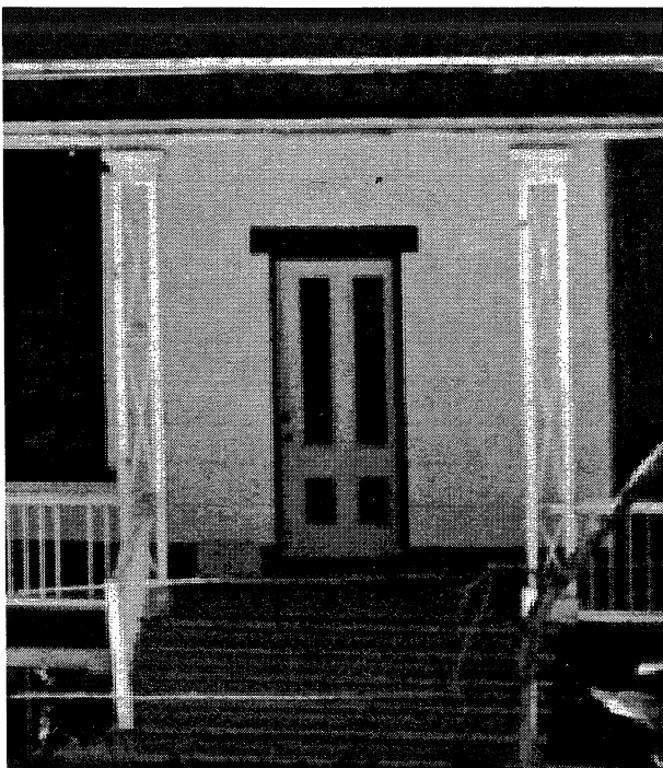
Original Wood Door
